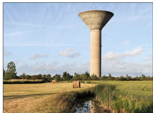
Le château d'eau Kulmino à Notre-Dame-de-Monts
