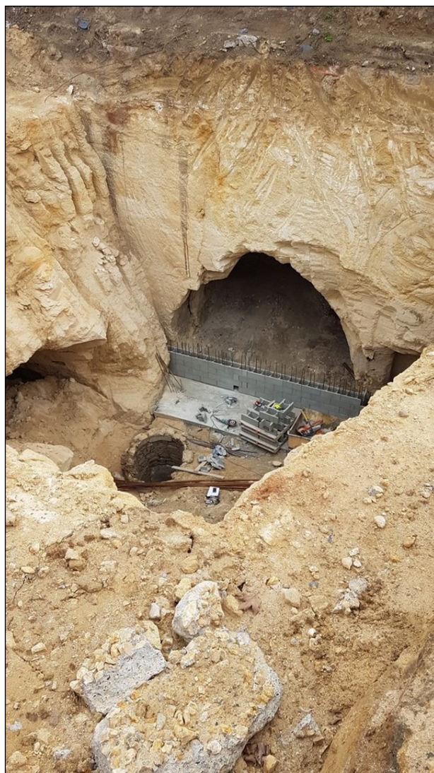
Cave cathédrale sous l'emplacement de la future Maison de santé du centre-bourg de Doué-en-Anjou
