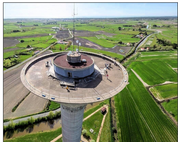
Plateforme panoramique de Kulmino à 70 m du sol
