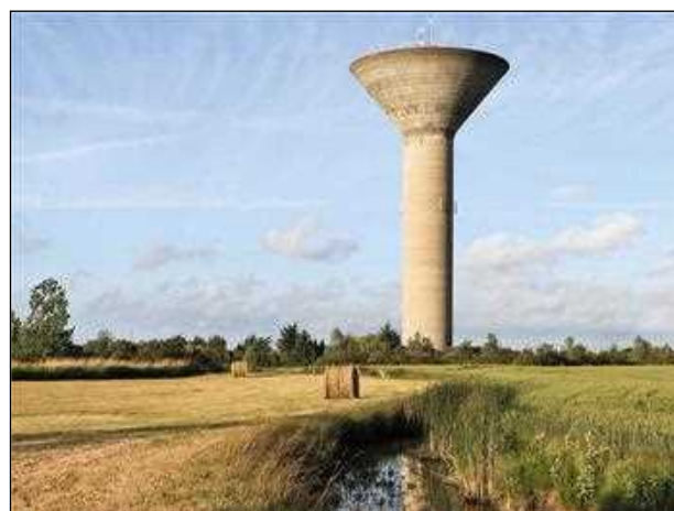
Le château d'eau Kulmino à Notre-Dame-de-Monts
