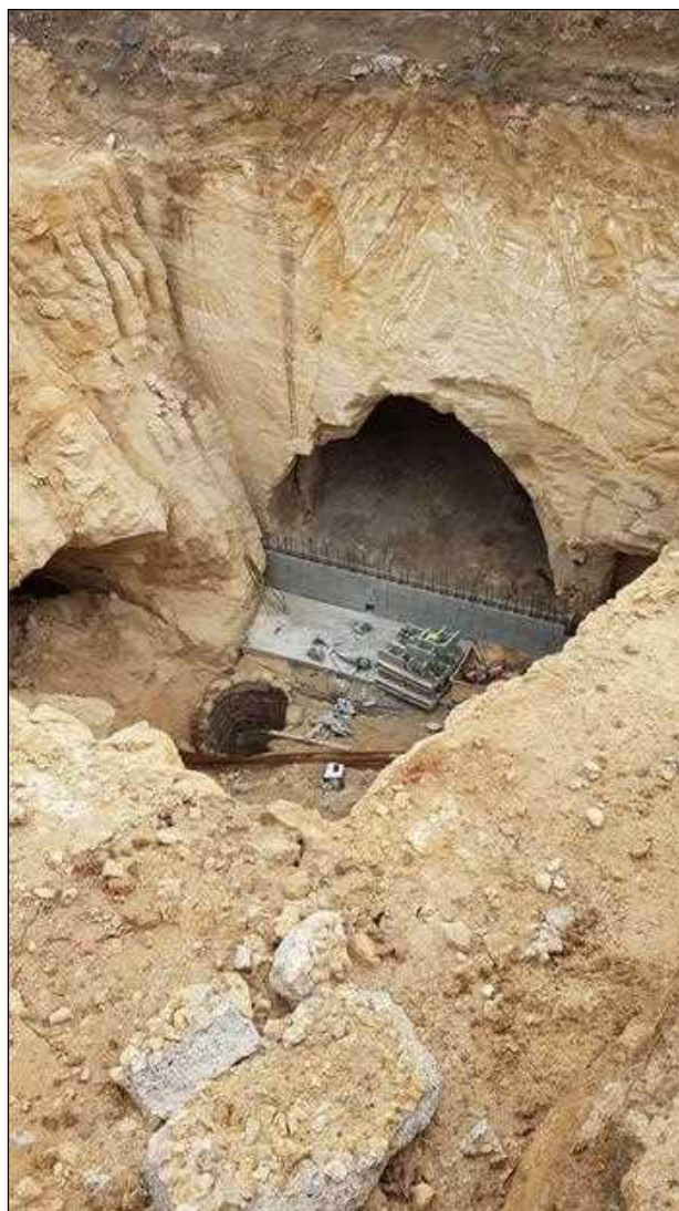
Cave cathédrale sous l'emplacement de la future Maison de santé du centre-bourg de Doué-en-Anjou
