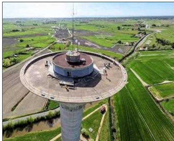
Plateforme panoramique de Kulmino à 70 m du sol
